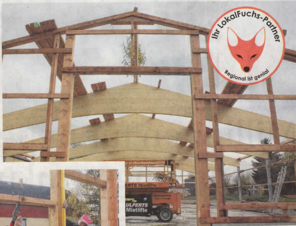
Egon und Mario Geister bei letzten Handgriffen an der neuen Lagerhalle in Bandelow, bevor die Gäste zum Richtfest kommen.
